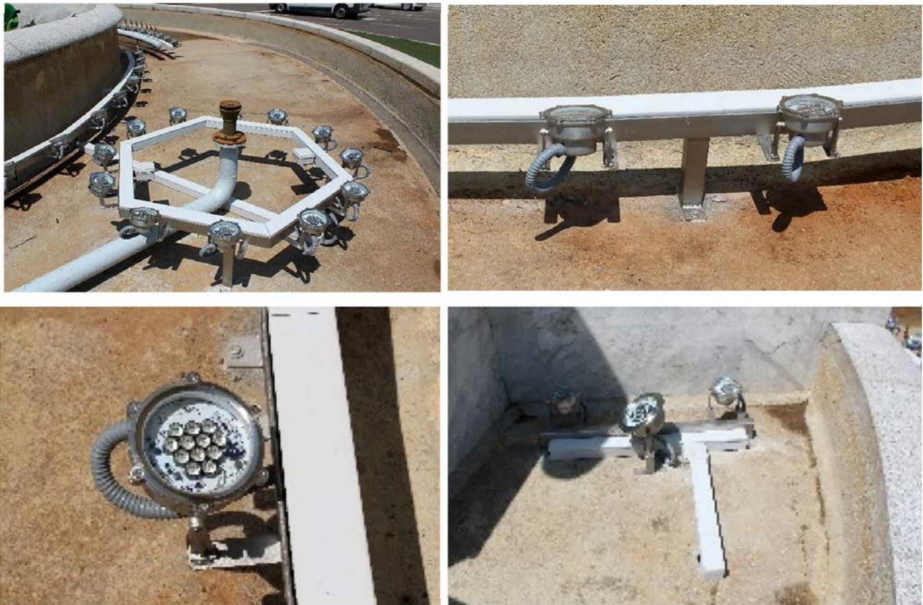
Figura 7. Detalles instalación de alumbrado de fuentes, construidas con el REBT de 2002. (C. de la Fuente, 2018).
