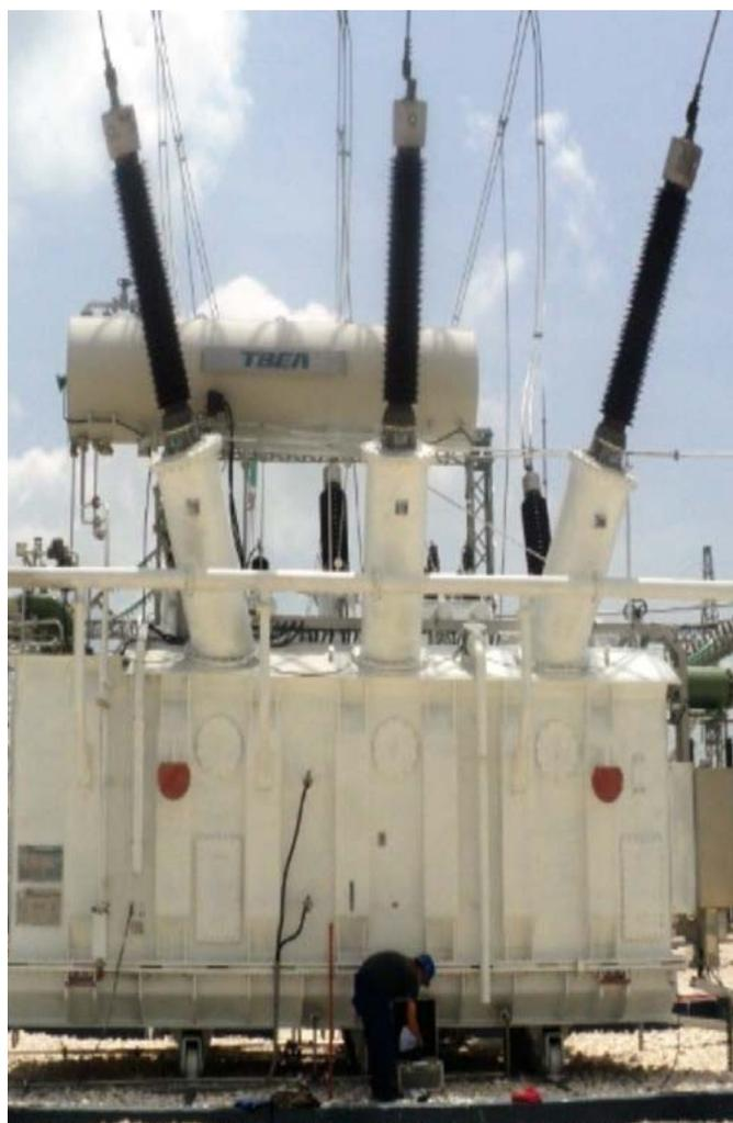
Figura 8. Autotransformador 125 MVA 220/110/11 kV.
